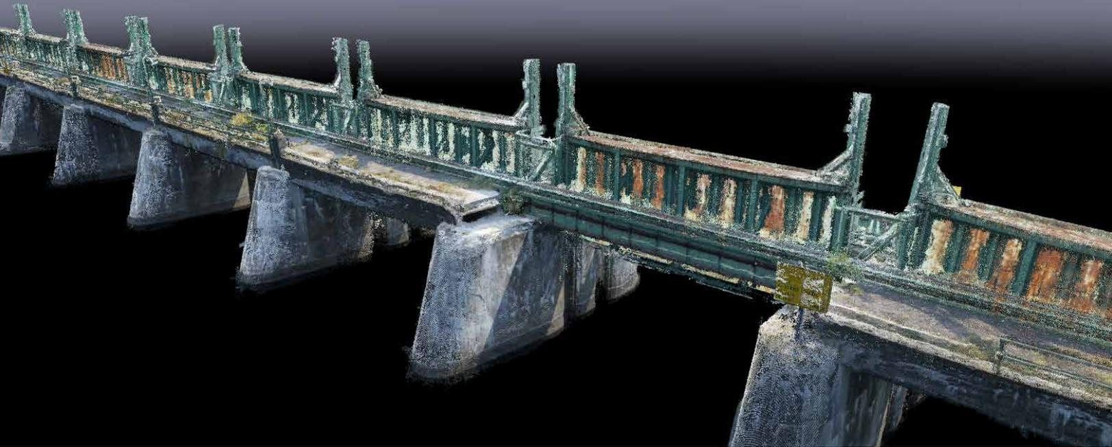
Die Daten wurden mit einer unbemannten Flugplattform von microdrones mit höchster Präzision erfasst. Mithilfe dieser Daten erstellte eine Behörde für Denkmalschutz ein 3D-Modell des Staudamms, anhand dessen die Ingenieure ihr Sanierungsangebot entwerfen konnten.
