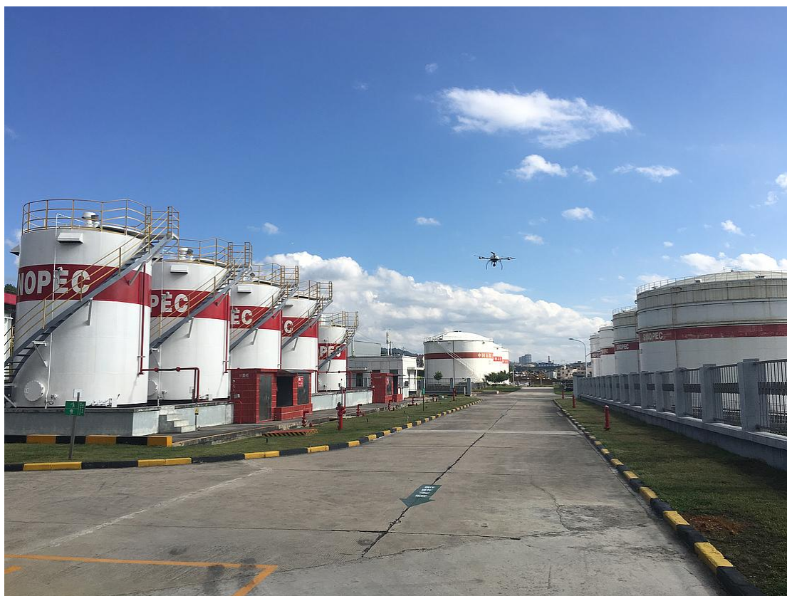
中石化正在使用 Microdrones md4-1000 检查燃气储存罐
