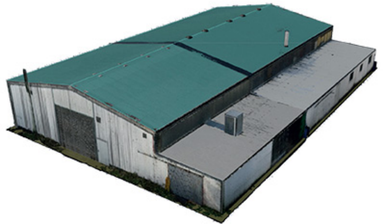
Hallensanierung als Maßanfertigung: Die einzelnen Fassaden- und Dachelemente werden in der Regel individuell angefertigt, was ein millimetergenaues Aufmaß des Bestandes voraussetzt. Grafiken: Wierig Profiltechnik
